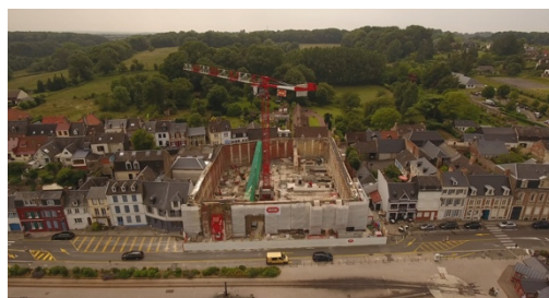
Photos du chantier – Mai 2018 / Crédit photo Kryzalid Films
